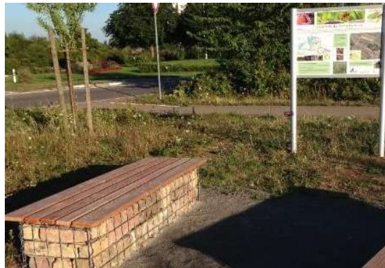
Gabione mit Buntsandsteinen und Sitzauflage, © M.Deubert
